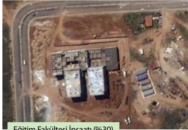
Eğitim Fakültesi İnşaatı (%30)
