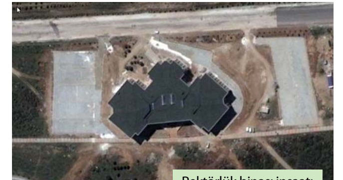
Rektörlük binası inşaatı
