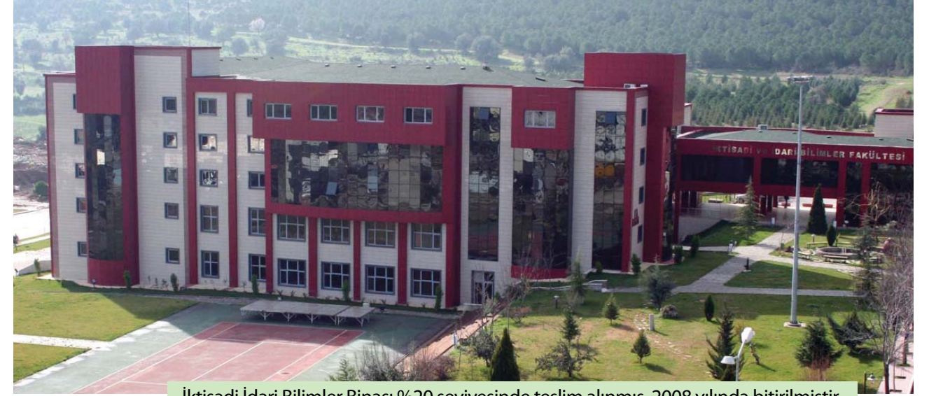
İktisadi İdari Bilimler Binası %20 seviyesinde teslim alınmış. 2008 yılında bitirilmiştir.
