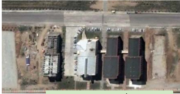
Fen Edebiyat Fakültesi İnşaatı (%50)
